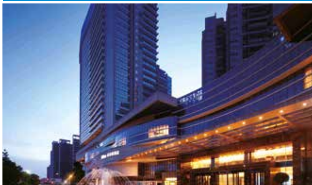
Lieu : Foshan - Chine Unités intérieures : Ventilo-convecteurs
