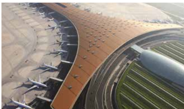
Lieu : Beijing - Chine Unités intérieures : Ventilo-convecteurs
