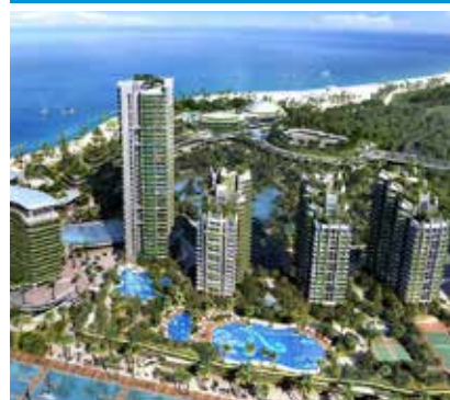
Lieu : Selangor - Malaisie Unités extérieures : Groupe d'eau glacée à vis condensée par eau
