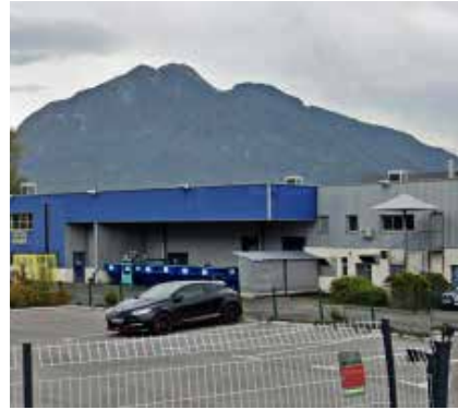
Lieu : Marnaz Équipements installés : VRF, Gainables, Centralisée
