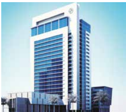
Lieu : Solo - Indonésie Unités extérieures : Groupe d'eau glacée centrifuge ultra efficace
