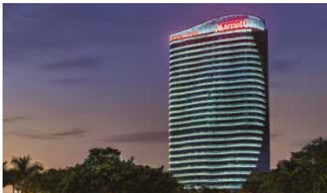
Lieu : Foshan - Chine Équipements installés : Ventilo-convecteurs
