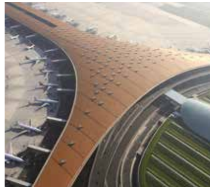
Lieu : Beijing - Chine Unités extérieures : Groupe d'eau glacée centrifuge et groupe d'eau glacée à vis condensé par eau
