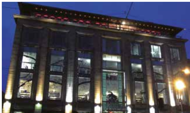
Lieu : Édimbourg Unités intérieures : Ventilo-convecteurs
