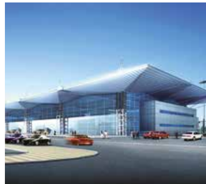
Lieu : Maputo - Mozambique Unités intérieures : VRF V4+
