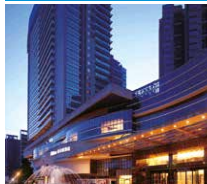
Lieu : Foshan - Chine Unités extérieures : Groupe d'eau glacée centrifuge et groupe d'eau glacée à vis condensé par eau
