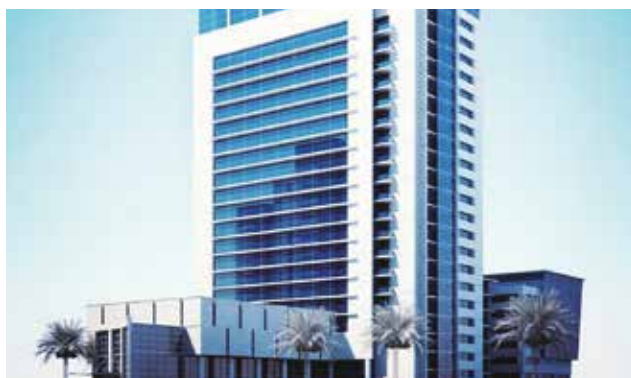
Lieu : Solo - Indonésie Unités intérieures : Ventilo-convecteurs
