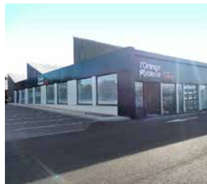
Lieu : Perpignan Équipements installés : VRF, Gainables
