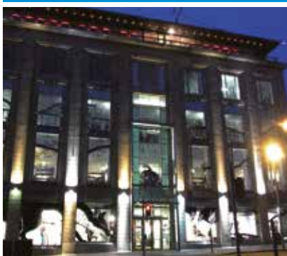
Lieu : Édimbourg - Royaume-Uni Unités extérieures : Groupes d'eau glacée modulaires
