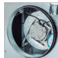
Moteurs Ventilateur de type plug-fan équipé de moteurs EC monophasé
