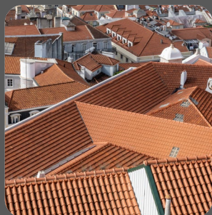
Toiture en tuile
