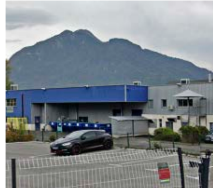
Lieu : Marnaz Équipements installés : VRF, Gainables, Centralisée
