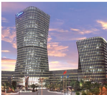
Lieu : Shunde - Chine Unités extérieures : Groupe d'eau glacée centrifuge et groupe d'eau glacée à vis condensé par eau
