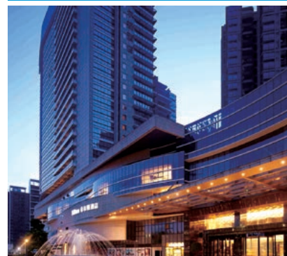
Lieu : Foshan - Chine Unités extérieures : Groupe d'eau glacée centrifuge et groupe d'eau glacée à vis condensé par eau
