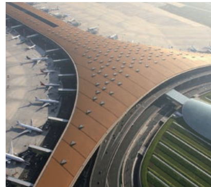
Lieu : Beijing - Chine Unités extérieures : Groupe d'eau glacée centrifuge et groupe d'eau glacée à vis condensé par eau
