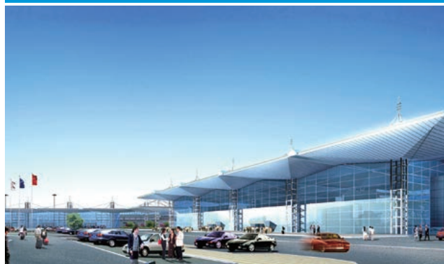
Lieu : Maputo - Mozambique Unités intérieures : Ventilo-convecteurs
