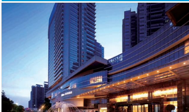
Lieu : Foshan - Chine Unités intérieures : Ventilo-convecteurs
